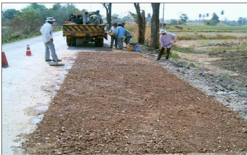
รูปที่ 3.6-5 นำวัสดุชั้นทางที่ได้มาตรฐานตามที่กำหนดมาทดแทนส่วนที่ขุดออกไป
