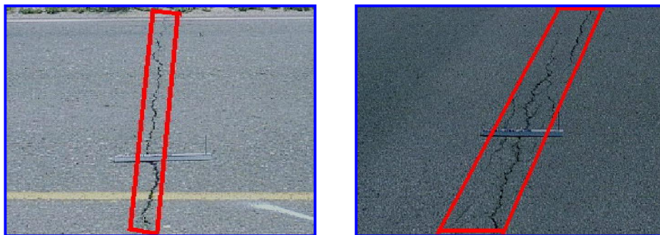
รูปที่ 2.20 ตัวอย่างการวัดปริมาณความเสียหายประเภทรอยแตกตามยาว / ขวาง
