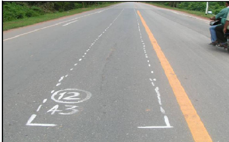
รูปที่ 3.2-1 การกำหนดพื้นที่สำหรับการฉาบน้ำยางแบบฟ็อกซีล
