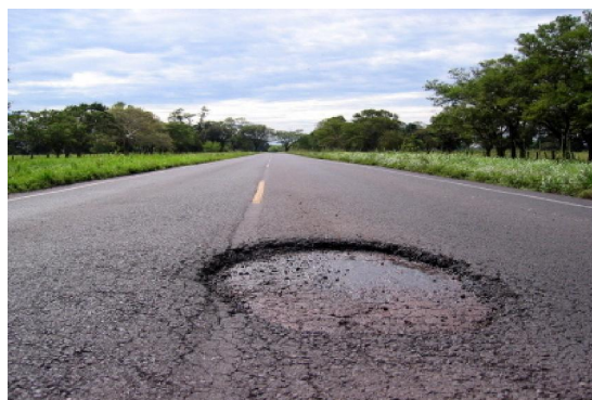
รูปที่ 2.1 ความเสียหายประเภทหลุมบ่อ
