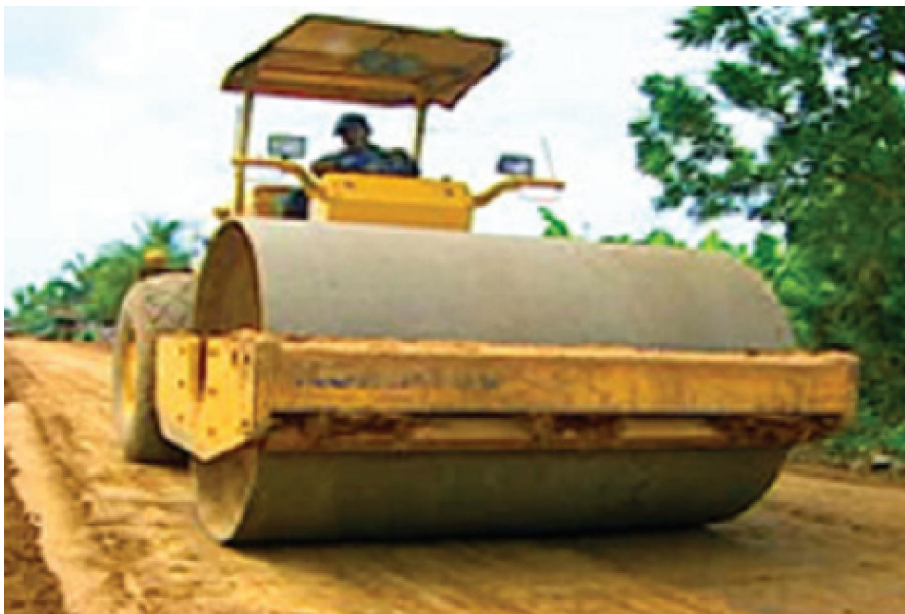
รูปที่ 5.3-5 บดอัดให้แน่นและสอดคล้องกับมาตรฐาน
