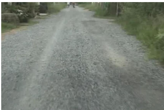
รูปที่ 2.39 ความเสียหายผิวทางลูกรังประเภทผิวทางหลุดร่อน
