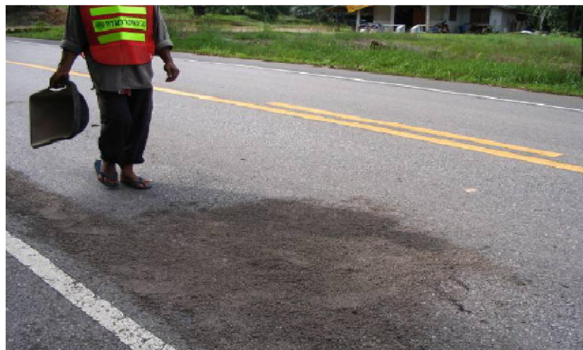
รูปที่ 3.1-4 การสาดทรายหรือหินฝุ่นปิดทับ
