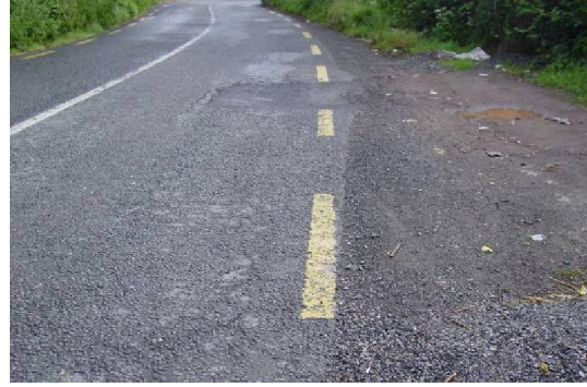
รูปที่ 2.14 ความเสียหายประเภทผิวทางหลุดร่อน
