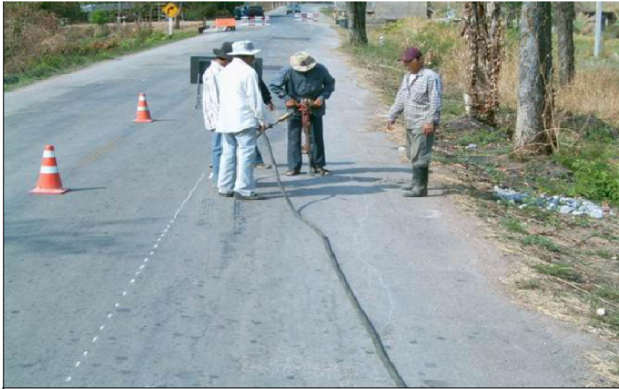
รูปที่ 3.6-1 การเตรียมพื้นที่สำหรับการซ่อม
