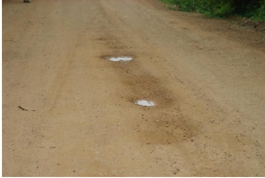
รูปที่ 2.37 ความเสียหายผิวทางลูกรังประเภทหลุมบ่อ
