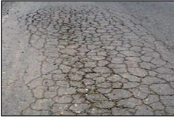
รูปที่ 2.21 ความเสียหายประเภทรอยแตกกร้าวแบบหนังจระเข้
