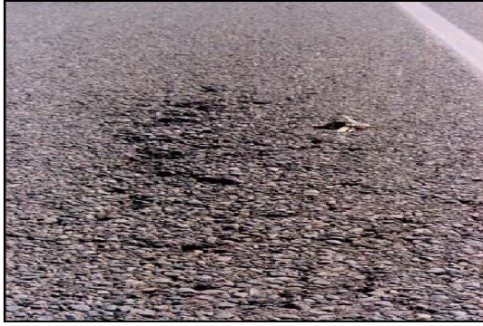
รูปที่ 2.14 ความเสียหายประเภทผิวทางหลุดร่อน
