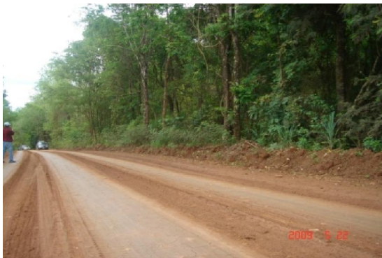
รูปที่ 2.38 ความเสียหายผิวทางลูกรังประเภทร่องล้อ
