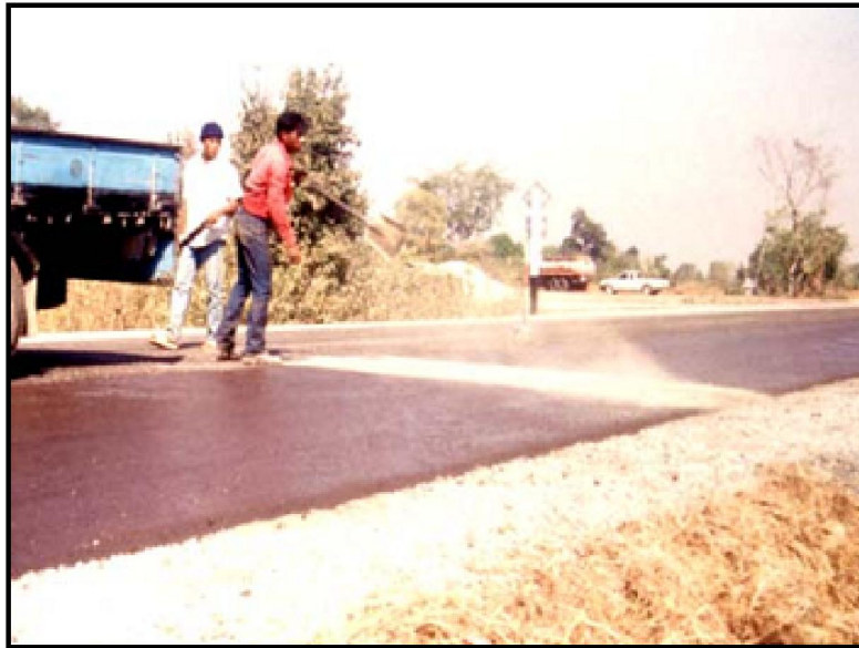
รูปที่ 3.4-6 การสาดทราย หรือหินฝุ่น บริเวณทางแยกหรือทางเชื่อม
