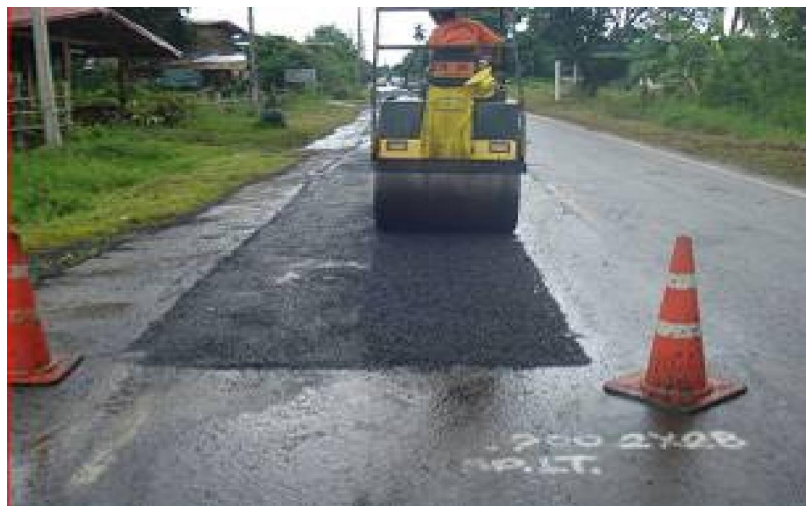
รูปที่ 3.6-8 การบดทับผิวทาง
