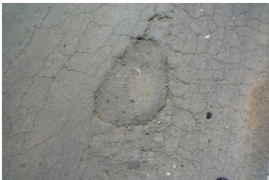
รูปที่ 2.11 ความเสียหายประเภทรอยปะซ่อมที่เสียหาย
