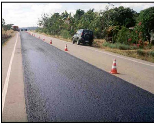
รูปที่ 3.4-4 ผิวทางสเลอรี่ซีลที่ฉาบเสร็จเรียบร้อยแล้ว
