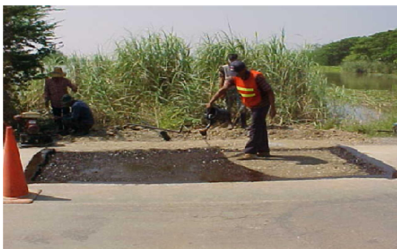
รูปที่ 3.6-6 การทำ Prime Coat
