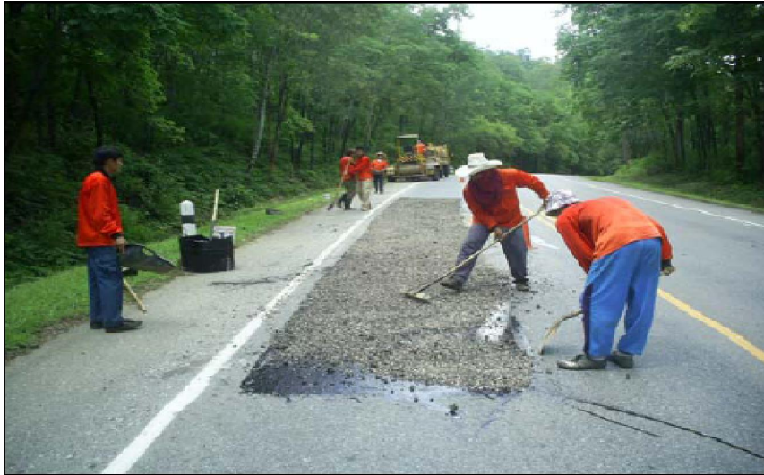
รูปที่ 3.3-3 โรยหินย่อยหรือกรวดย่อยปิดทับหน้าแอสฟัลต์
