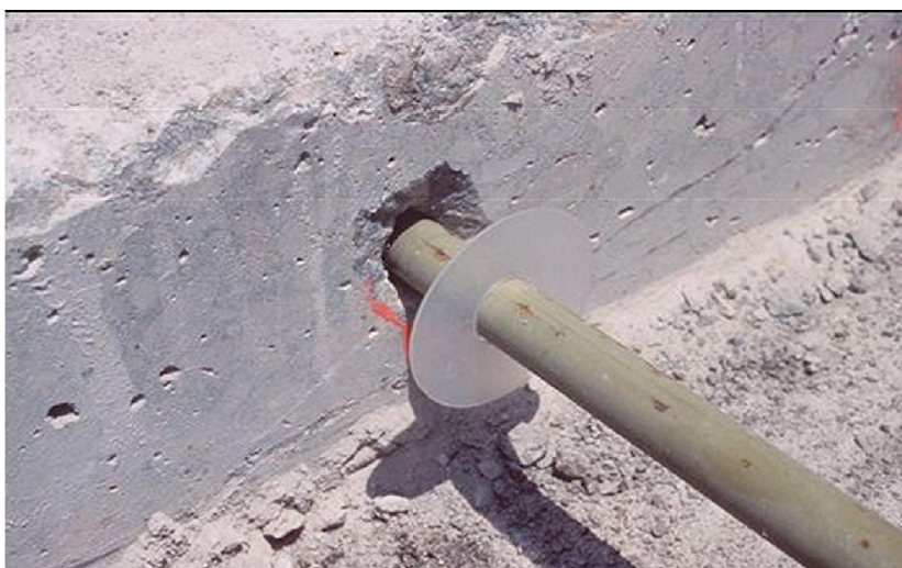
รูปที่ 4.4-11 การติดตั้งแหวนยางเพื่อป้องกันน้ำปูนไหลเข้าไปในปลอกเหล็กเดียว
