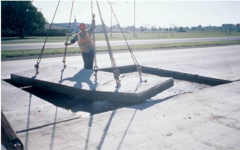
รูปที่ 4.4-8 การรื้อแผ่นคอนกรีตโดยวิธีการยกแผ่นคอนกรีตออก (Lift – out Method)
