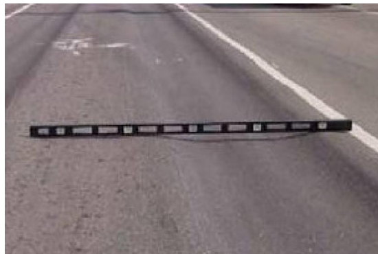
รูปที่ 2.7 ความเสียหายประเภทร่องล้อ
