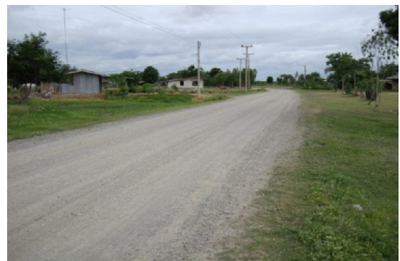
รูปที่ 2.39 ความเสียหายผิวทางลูกรังประเภทผิวทางหลุดร่อน
