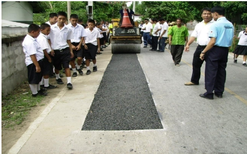
รูปที่ 3.5-5 การบดทับด้วยรถบดล้อเหล็ก
