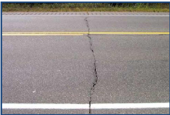
รูปที่ 2.18 ความเสียหายประเภทรอยแตกร้าวตามแนวขวาง
