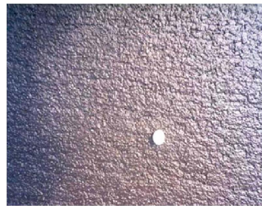
รูปที่ 3.4-4 ผิวทางสเลอรี่ซีลที่ฉาบเสร็จเรียบร้อยแล้ว
