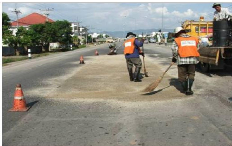
รูปที่ 3.7-4 สาดหินฝุ่นปิดทับก่อนเปิดการจราจร
