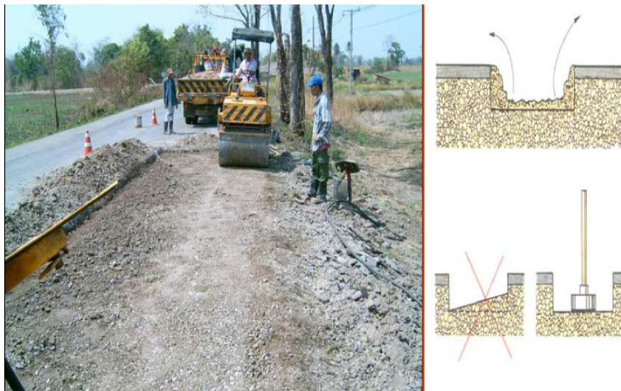
รูปที่ 3.6-4 การบดทับกันหลุมให้แน่นเรียบสม่ำเสมอ
