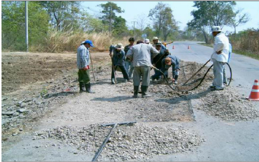
รูปที่ 3.6-3 การขุดรื้อชั้นผิวทาง และชั้นพื้นทางที่ชำรุดเสียหาย
