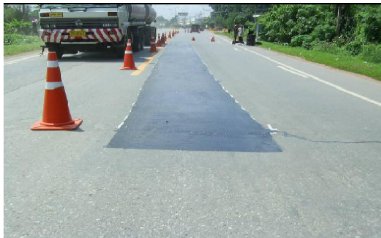
รูปที่ 3.2-3 ผิวทางเมื่อทำการฉาบน้ำยางฟ็อกซีลแล้วเสร็จ
