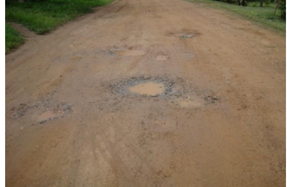
รูปที่ 2.37 ความเสียหายผิวทางลูกรังประเภทหลุมบ่อ
