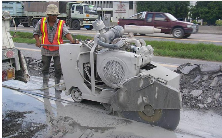
รูปที่ 4.4-6 การเลื่อยตัดแผ่นคอนกรีต
