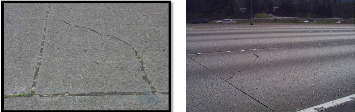
รูปที่ 2.29 ความเสียหายผิวทางคอนกรีตประเภทรอยแตกตามมุม
