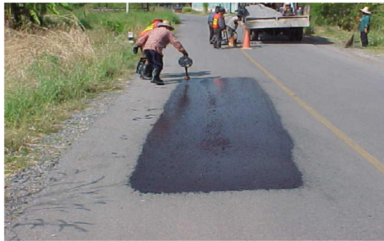
รูปที่ 3.2-2 ทำการฉาบน้ำยางฟ็อกซีล
