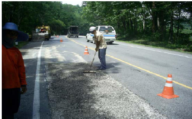
รูปที่ 3.3-5 กลี่ยหินย่อยให้กระจายอย่างสม่ำเสมอ
