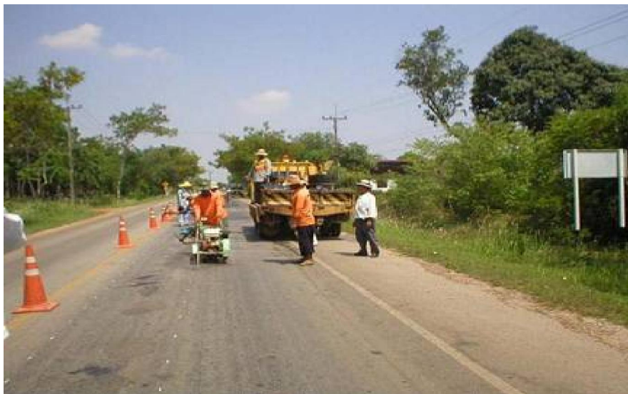
รูปที่ 3.6-2 การเลื่อยตัดผิวตามแนวเส้นขอบที่เตรียมไว้
