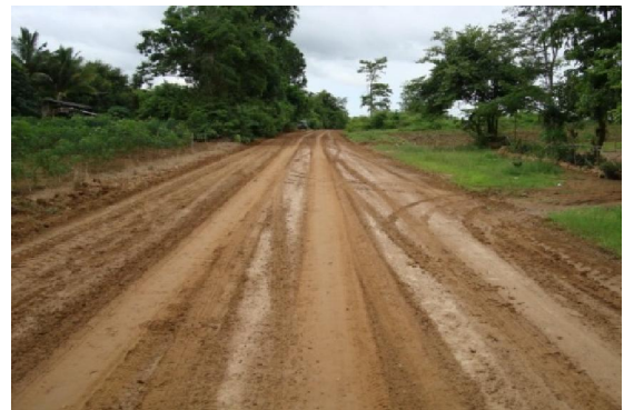
รูปที่ 2.38 ความเสียหายผิวทางลูกรังประเภทร่องล้อ
