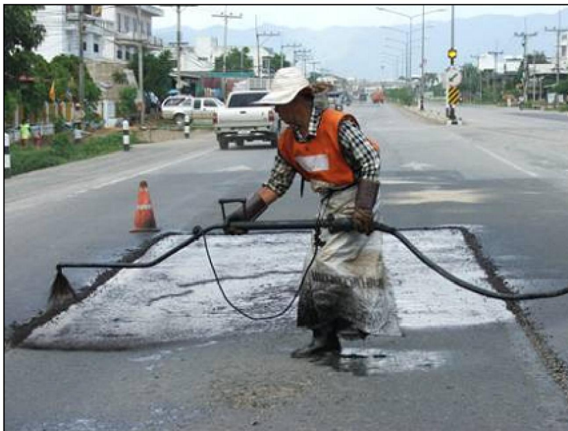
รูปที่ 3.7-1 การ Tack Coat ผิวทางเดิมที่ได้ทำความสะอาดเรียบร้อยแล้ว
