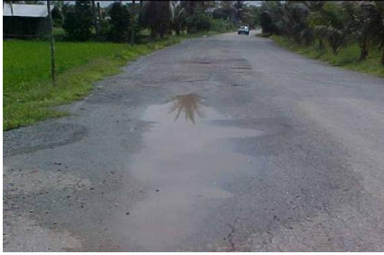
รูปที่ 2.4 ความเสียหายประเภทยุบตัวเป็นแอ่ง
