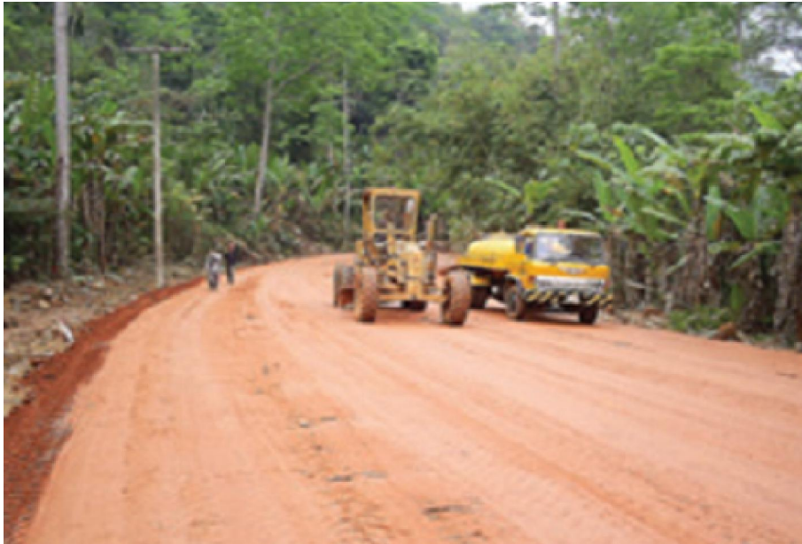
รูปที่ 5.3-4 รถบรรทุกกราดน้ำตามหลังรถเกรดเดอร์
