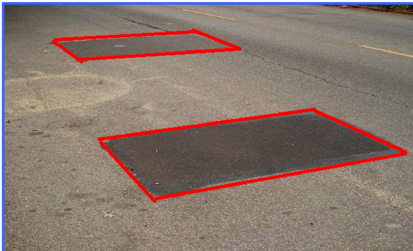
รูปที่ 2.13 ตัวอย่างการวัดประมาณความเสียหายประเภทรอยปะซ่อมที่เสียหาย
