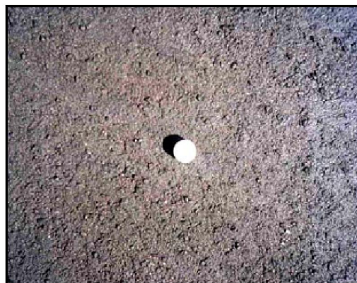
รูปที่ 3.4-5 ผิวทางสเลอรี่ซีลที่บ่มและแห้งแล้ว
