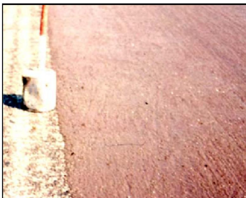
รูปที่ 3.4-5 ผิวทางสเลอรี่ซีลที่บ่มและแห้งแล้ว
