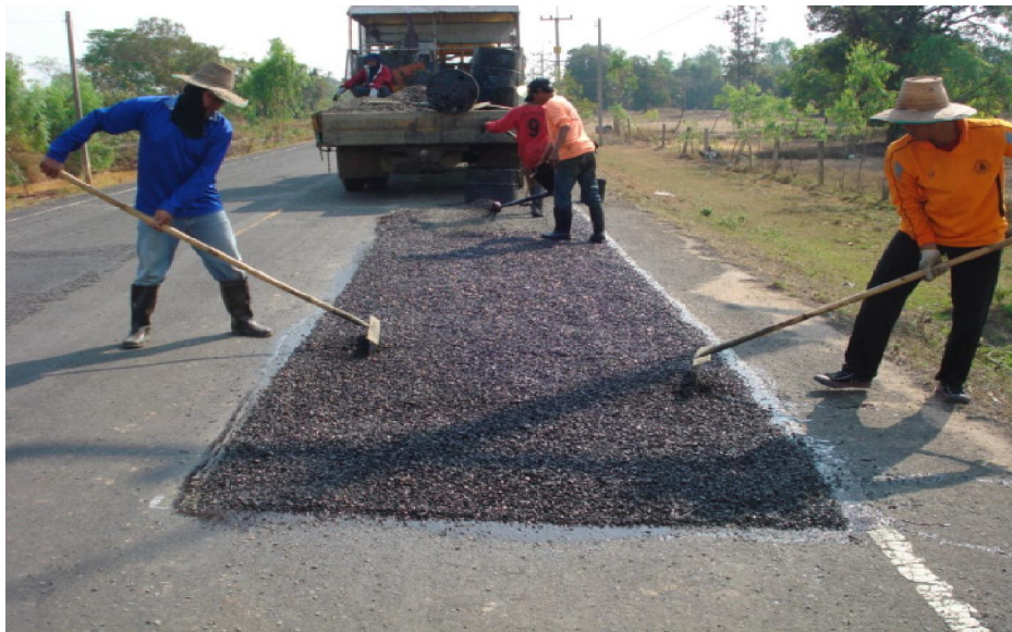
รูปที่ 3.5-4 การปูวัสดุ Pre – Mix
