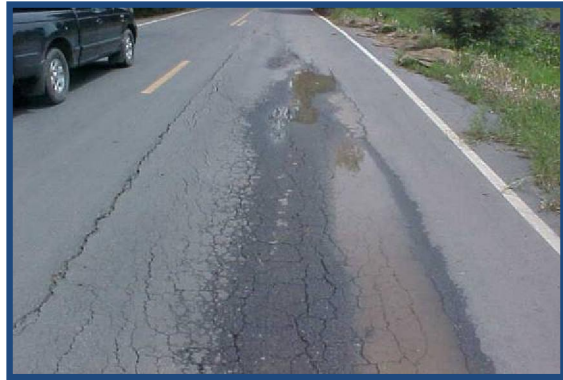
รูปที่ 2.21 ความเสียหายประเภทรอยแตกกร้าวแบบหนังจระเข้
