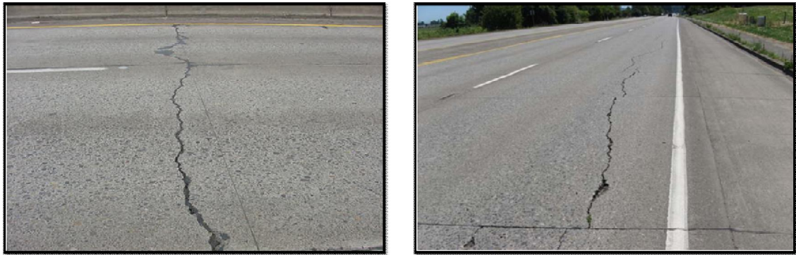
รูปที่ 2.24 ความเสียหายผิวทางคอนกรีตประเภทรอยแตกตามขวาง / ตามยาว
