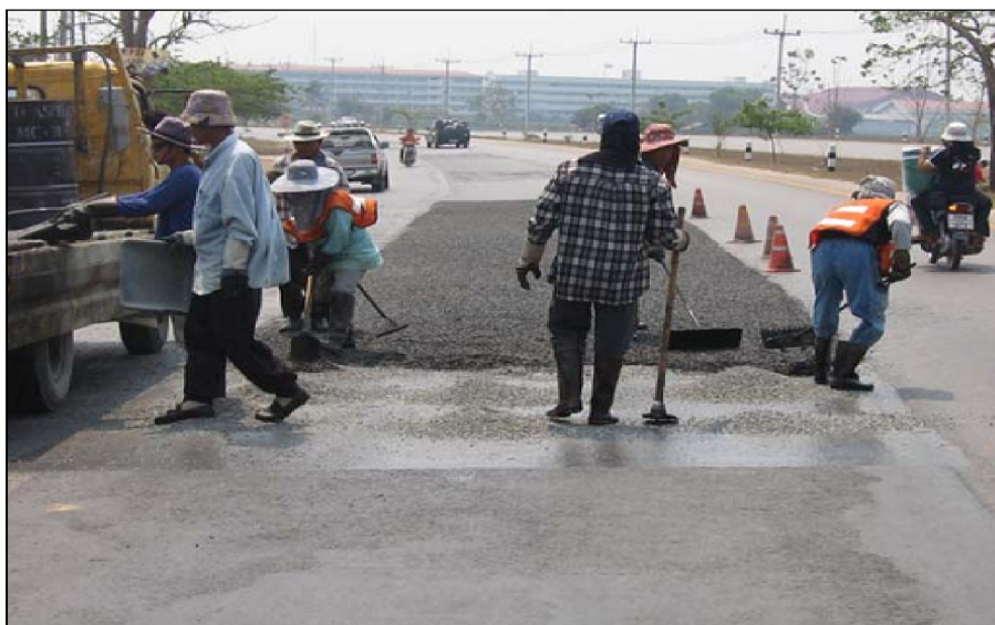
รูปที่ 3.7-2 การปูแอสฟัลต์ผสมเสร็จด้วยแรงงานคน
