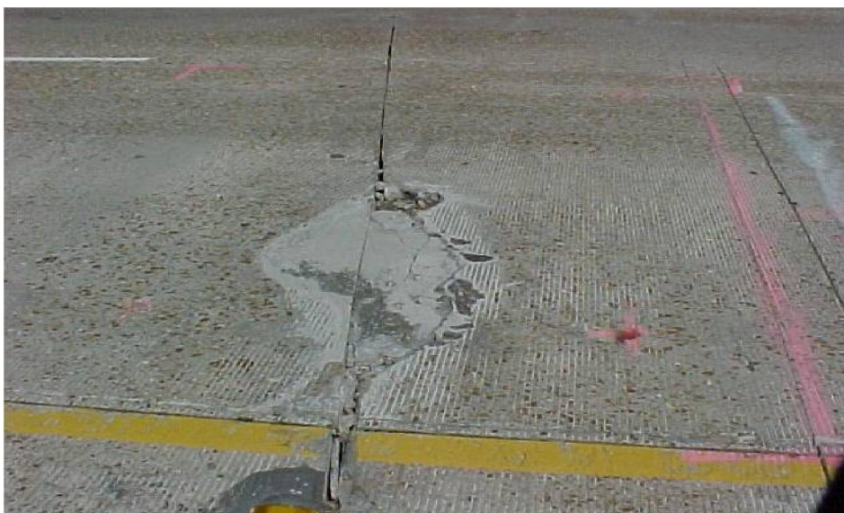
รูปที่ 4.3-1 การกำหนดขอบเขตความเสียหาย
