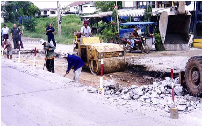
รูปที่ 4.4-9 การปรับปรุงชั้นพื้นทางใต้แผ่นคอนกรีตเดิม
