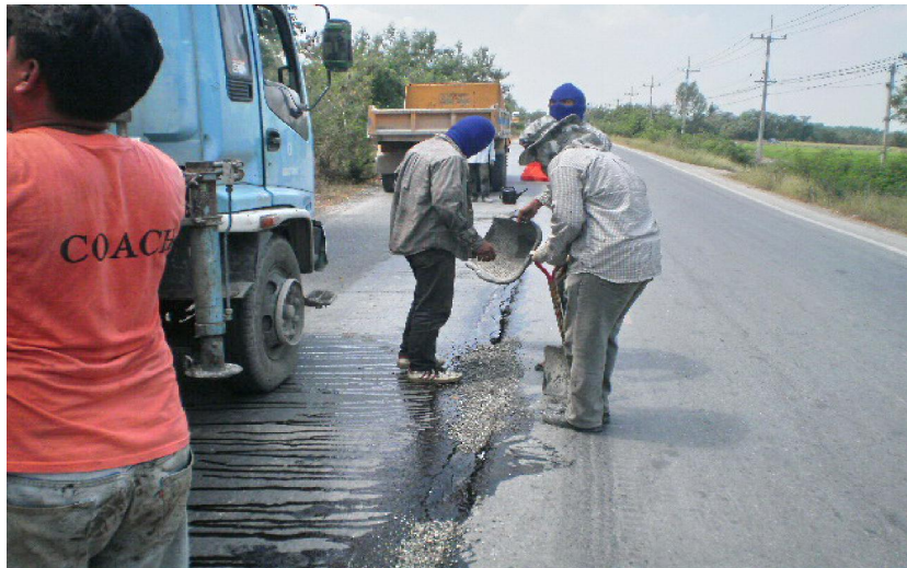
รูปที่ 3.1-3 การอุดรอยแตกที่มีความกว้างมากกว่าหรือเท่ากับ 5 มิลลิเมตร
