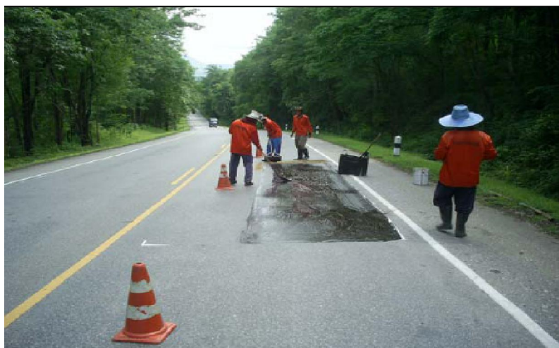
รูปที่ 3.3-2 พ่นหรือราดแอสฟัลต์ลงบนพื้นที่ทำความสะอาด
