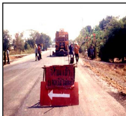
รูปที่ 3.4-1 การเตรียมพื้นที่สำหรับฉาบผิวทางแบบสเลอรี่ซีล
