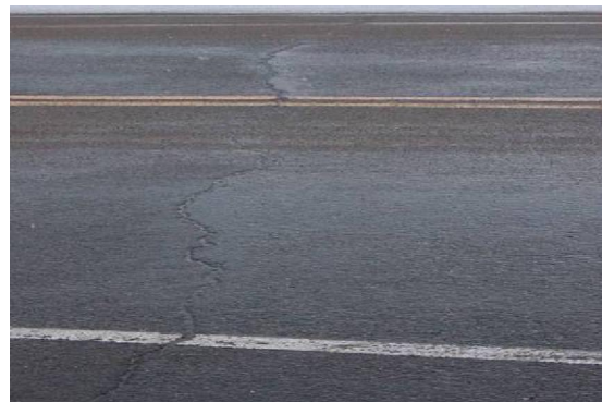
รูปที่ 2.18 ความเสียหายประเภทรอยแตกร้าวตามแนวขวาง
