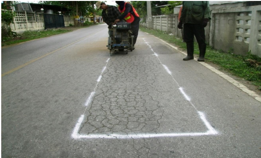
รูปที่ 3.5-1 ตัดขอบตามพื้นที่ที่จะทำการปะซ่อม
