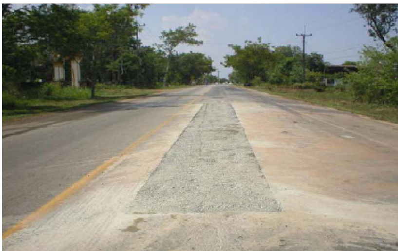
รูปที่ 3.5-6 การสาดหินฝุ่นปิดทับกรณีปูทับด้วย Cold Mix
