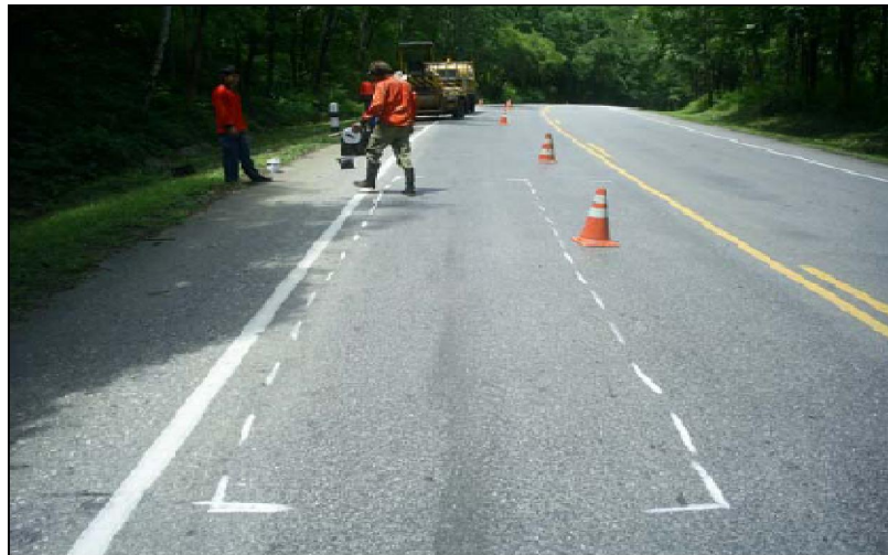
รูปที่ 3.3-1 กำหนดพื้นที่สำหรับการฉาบผิวทางแบบซีฟซีล
