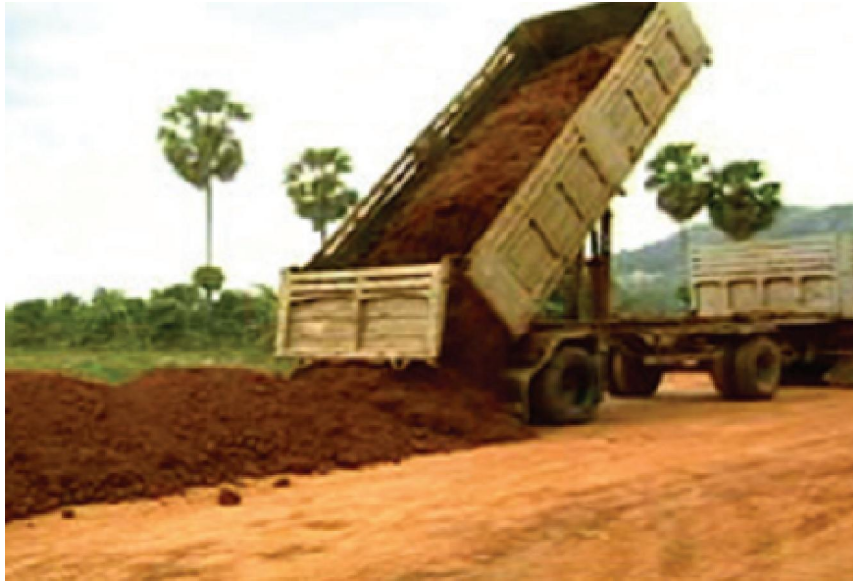
รูปที่ 5.3-2 กองลูกรังให้เป็นลักษณะรายการ
