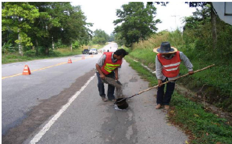
รูปที่ 3.1-2 การอุดรอยแตกที่มีความกว้างน้อยกว่า 5 มิลลิเมตร
