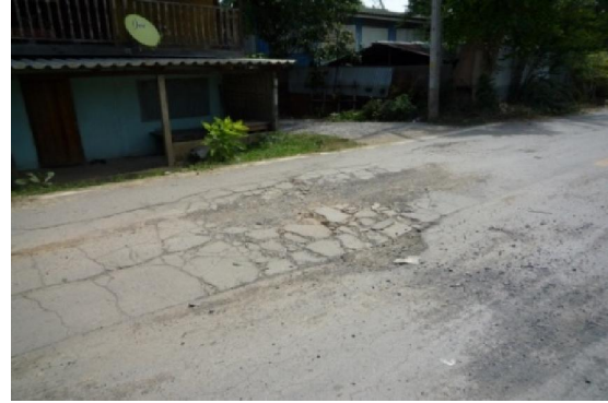
รูปที่ 2.4 ความเสียหายประเภทยุบตัวเป็นแอ่ง
