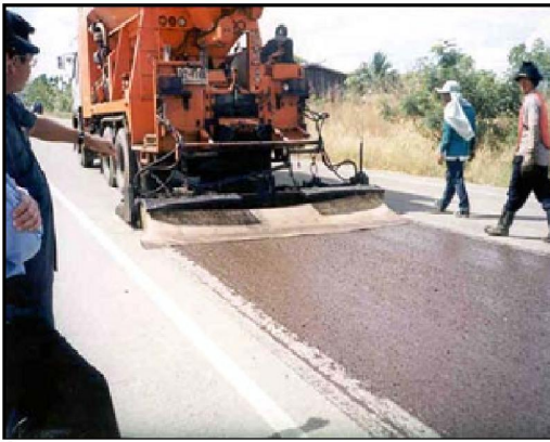
รูปที่ 3.4-3 การฉาบผิวทางสเลอรี่ซีล
