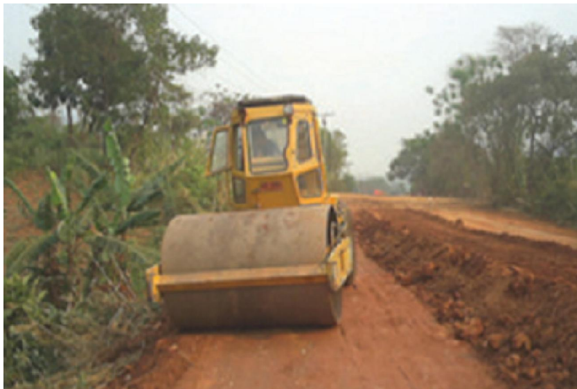
รูปที่ 5.3-3 ปรับระดับผิวทางลูกรังให้เป็นไปตามแบบกำหนด
