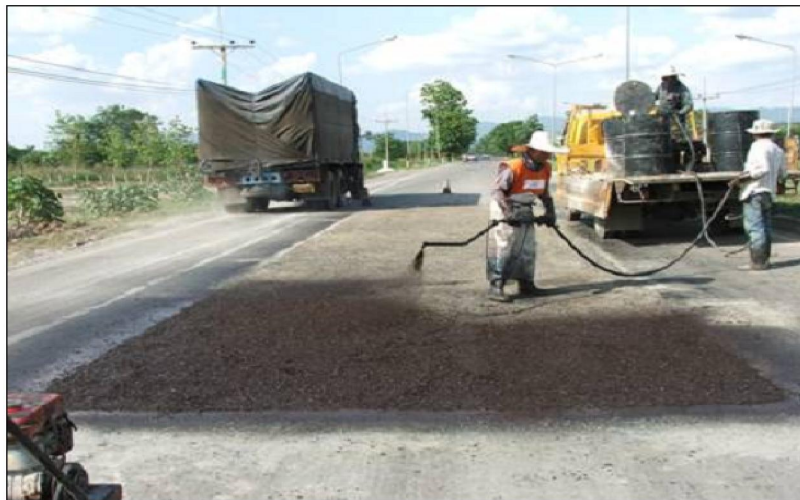
รูปที่ 3.7-3 ราวแอสฟัลต์เพื่ออุดช่องว่างระหว่างหินฝุ่นแห้ง
