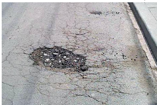
รูปที่ 2.1 ความเสียหายประเภทหลุมบ่อ
