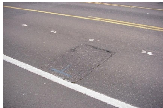
รูปที่ 2.11 ความเสียหายประเภทรอยปะซ่อมที่เสียหาย
